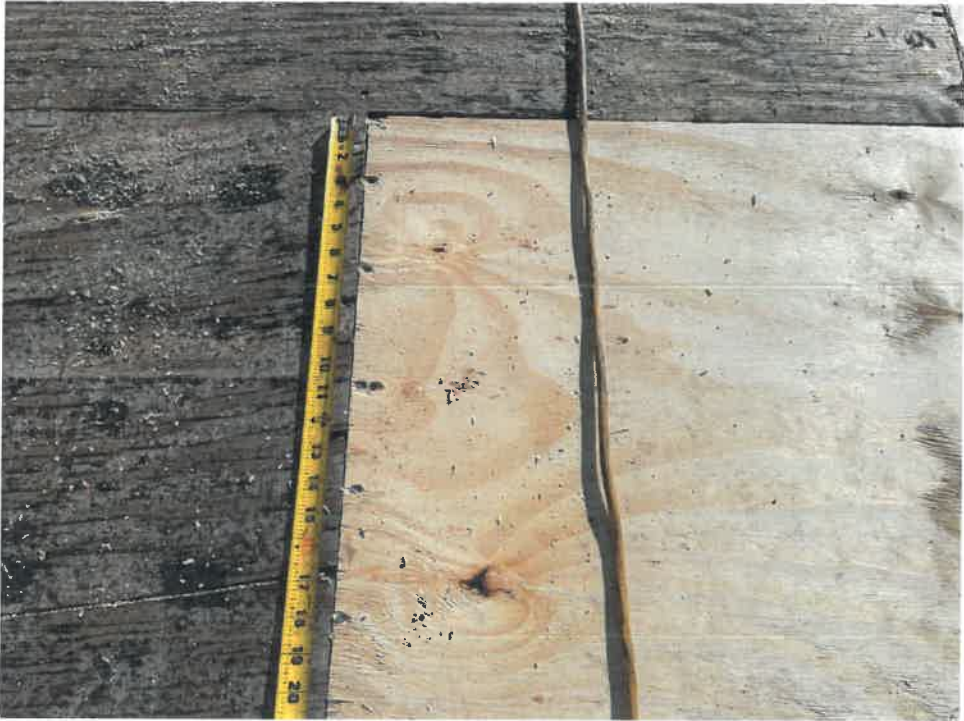
Figure 4 – Sheathing Edge Fastener Edge Spacing
