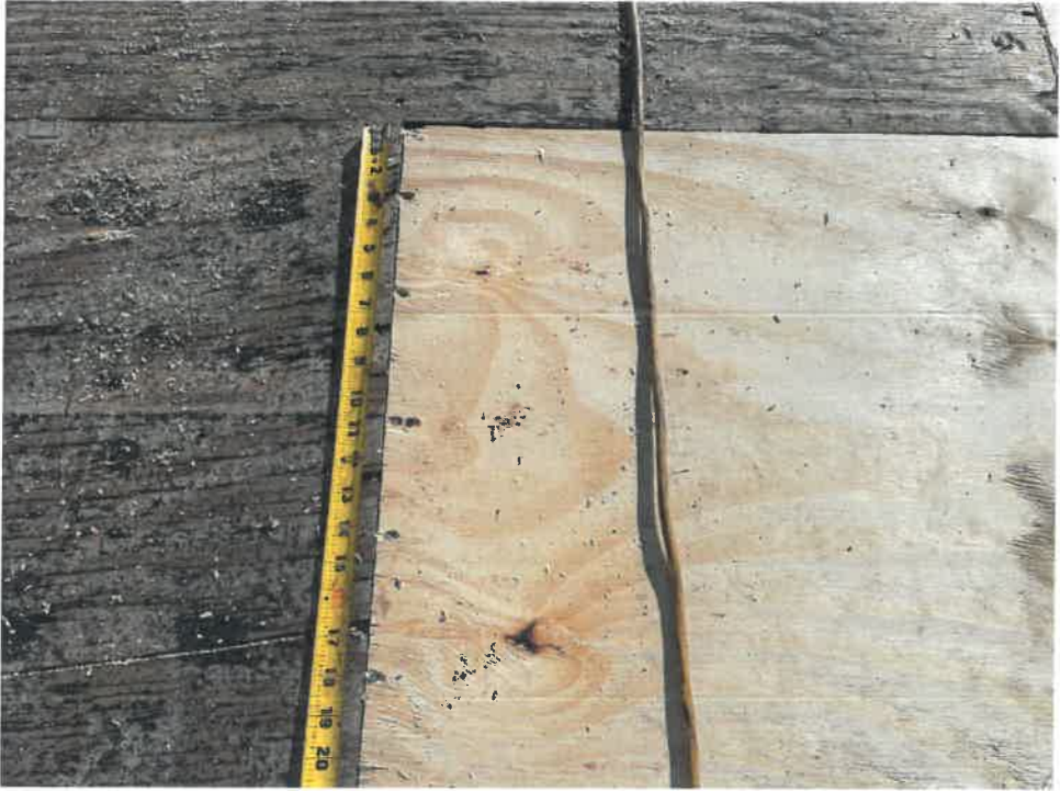
Figure 4 – Sheathing Edge Fastener Edge Spacing
