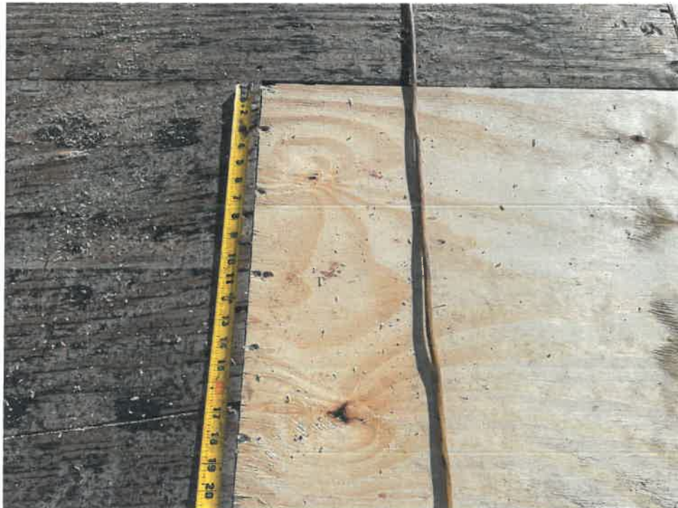
Figure 4 – Sheathing Edge Fastener Edge Spacing
