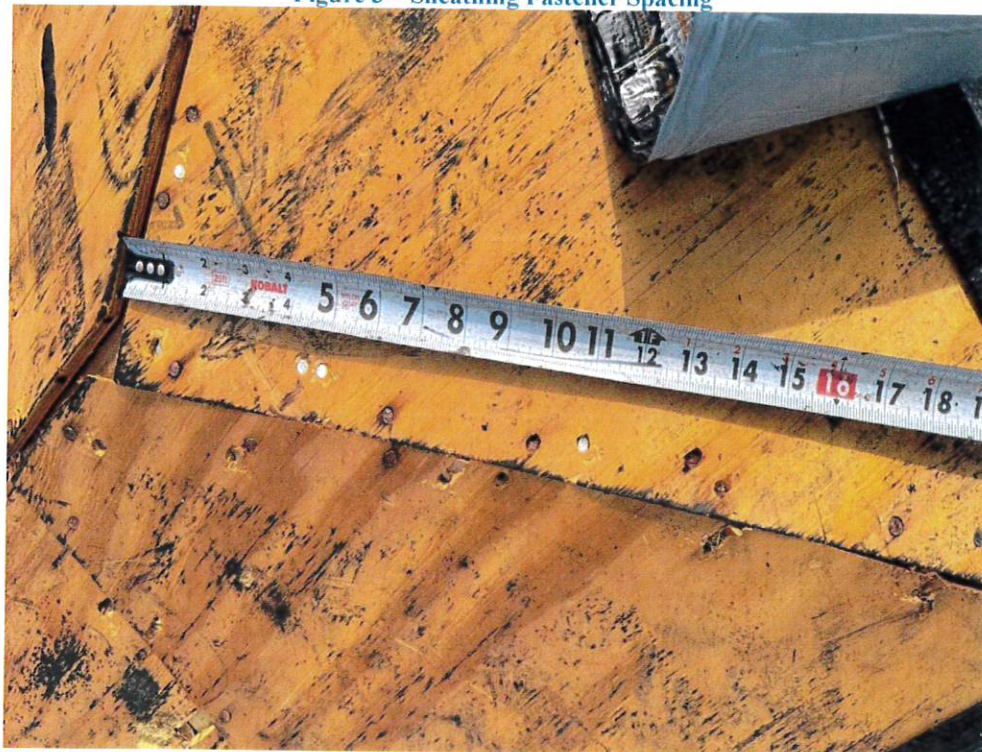
Figure 4 – Sheathing Edge Fastener Edge Spacing
