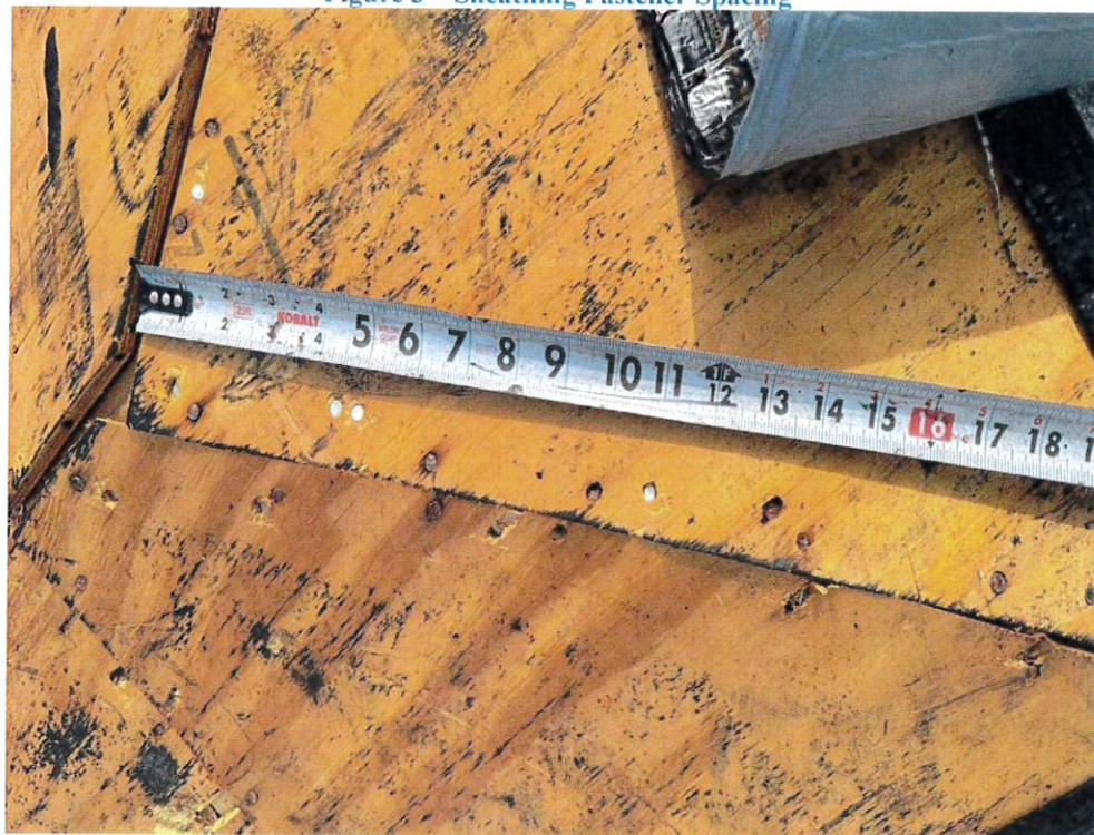
Figure 4 – Sheathing Edge Fastener Edge Spacing
