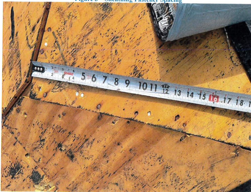
Figure 4 – Sheathing Edge Fastener Edge Spacing
