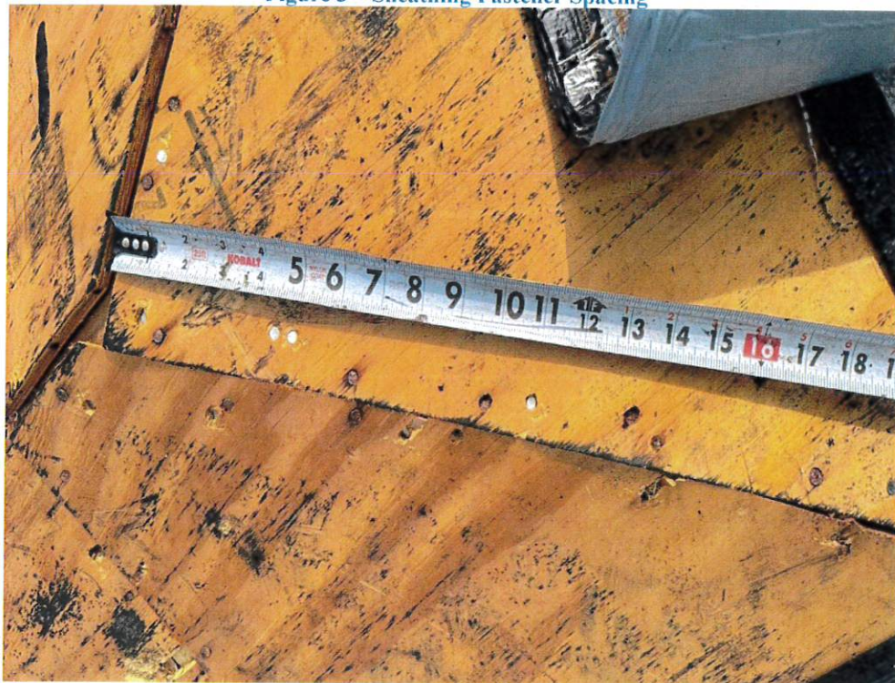
Figure 4 – Sheathing Edge Fastener Edge Spacing
