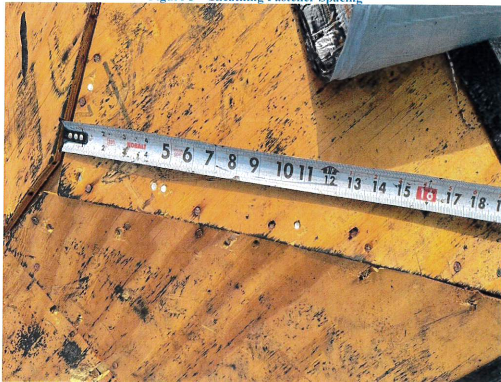
Figure 4 – Sheathing Edge Fastener Edge Spacing
