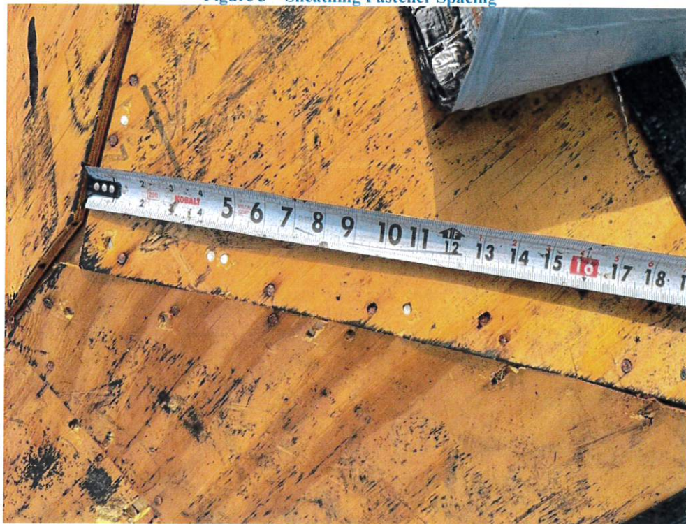
Figure 4 – Sheathing Edge Fastener Edge Spacing
