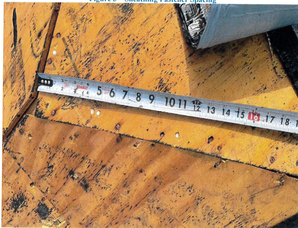
Figure 4 – Sheathing Edge Fastener Edge Spacing
