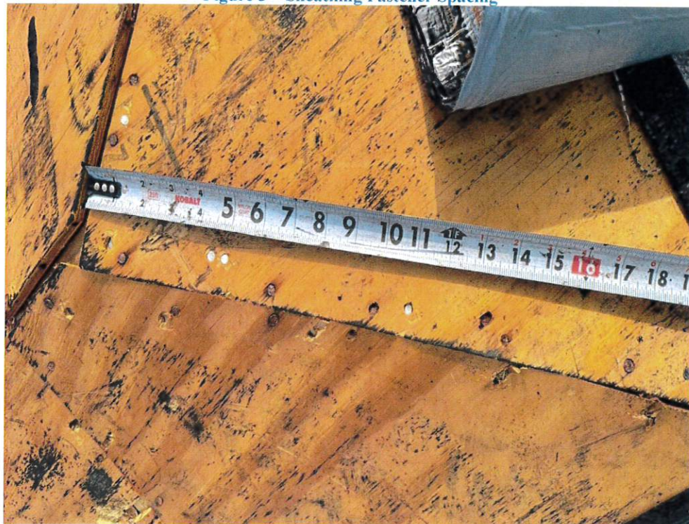
Figure 4 – Sheathing Edge Fastener Edge Spacing
