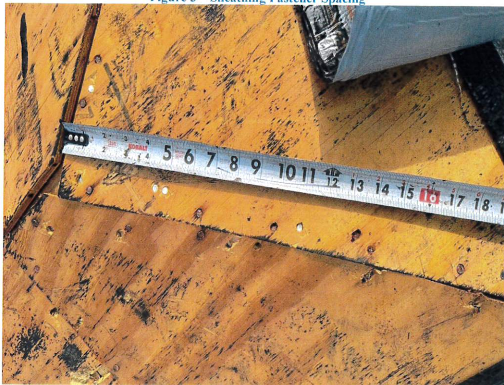
Figure 4 – Sheathing Edge Fastener Edge Spacing
