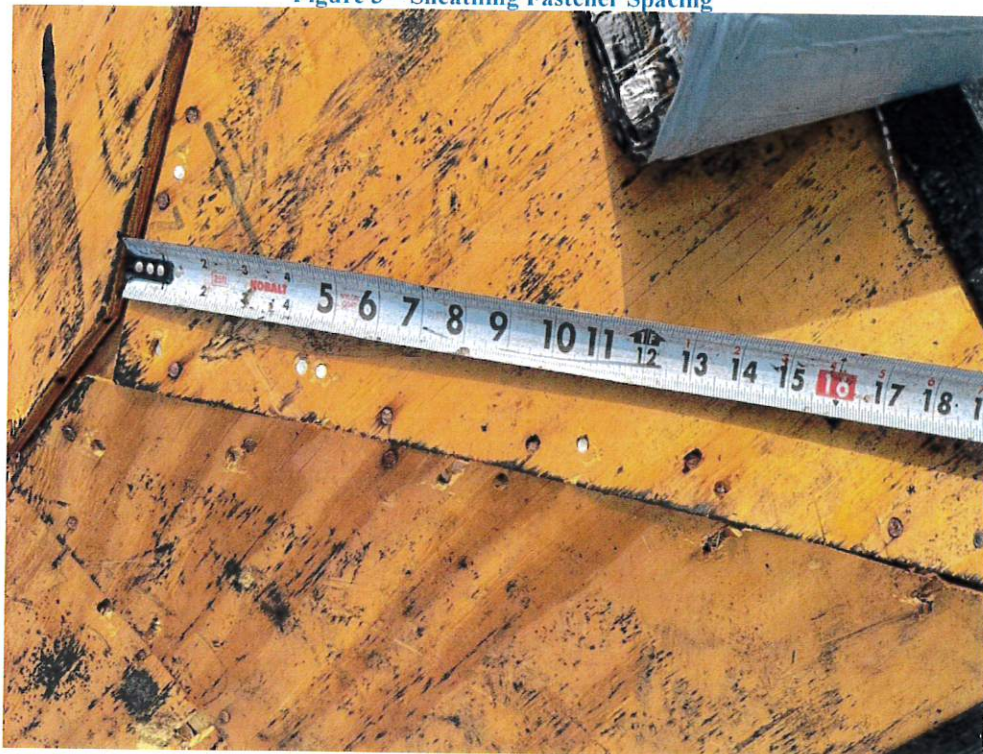
Figure 4 – Sheathing Edge Fastener Edge Spacing
