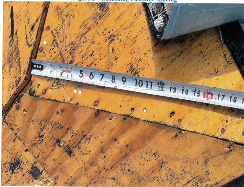
Figure 4 – Sheathing Edge Fastener Edge Spacing
